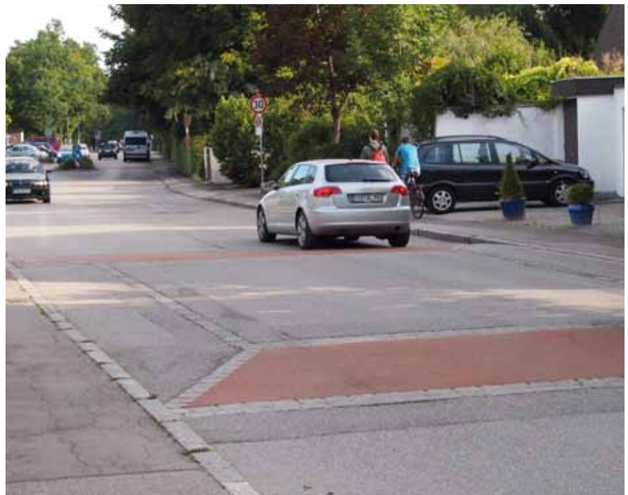
Teilaufpflasterung – Rampenneigung und Abstand bestimmen die Wirksamkeit
