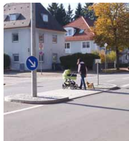
Mittelinsel – Aufteilung des Querungsvorganges in zwei Etappen
