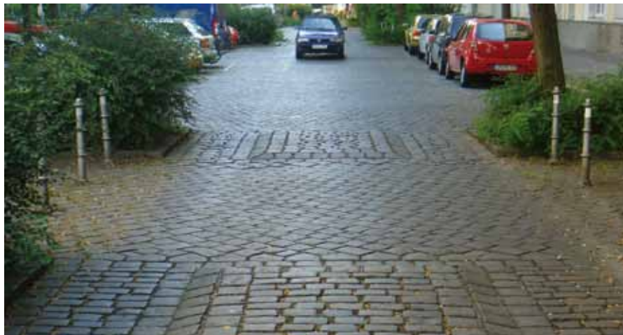
Plateaupflasterung – Bei starkem Bus- und Radverkehr sinnvoll
