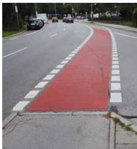
Radverkehrsfurt – Einfärbung zur Verdeutlichung des Vorranges für Radfahrer
