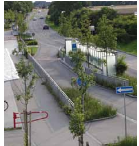
Haltestelle im Schulbereich – Separate Fahrspur verhindert Queren über die Fahrbahn
